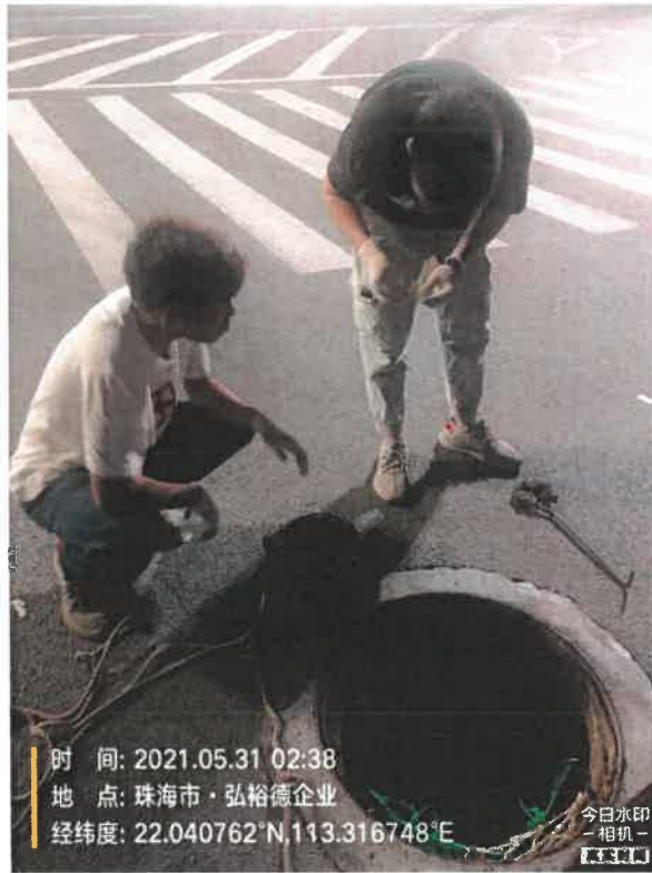
图 2：外部管网排查采样
